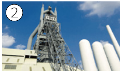
東田第一高炉跡
